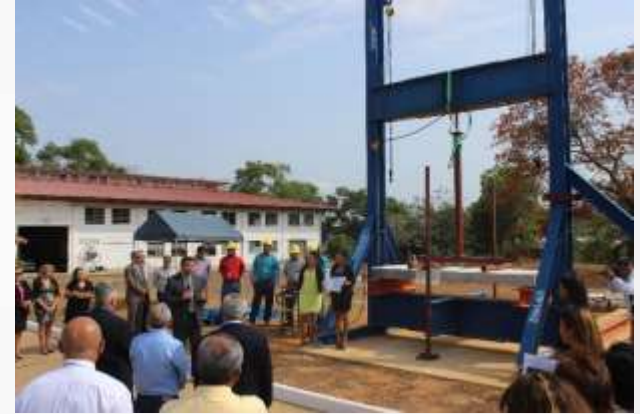
Marco de Prueba Estructural
